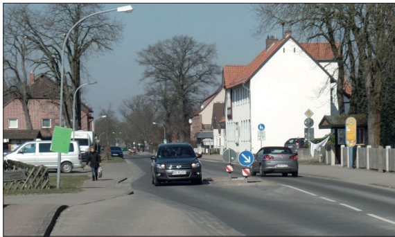
Hauptstraße Ortsdurchfahrt L 292
